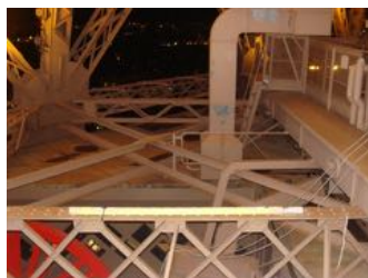
FIGURE 8.15 – Corde optique posée sur la Tour Eiffel ©OSMOS
