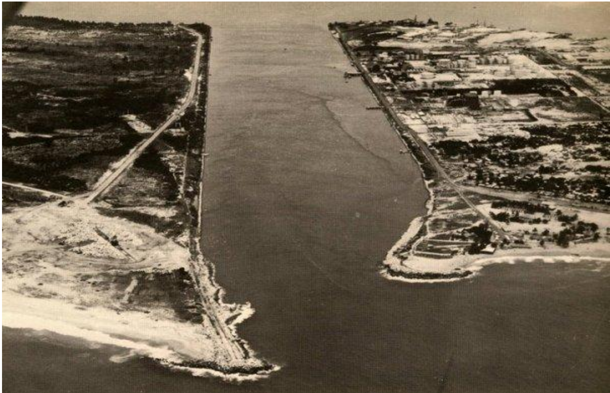
Figure 1 : la construction du port de Vridi canal
