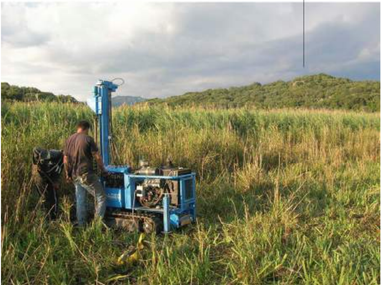
Figure 118 : photographie du carottier sur la position du sondage CAN 3
