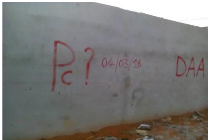
Figure VII-2 : inscription sur le mur d'une maison en construction
