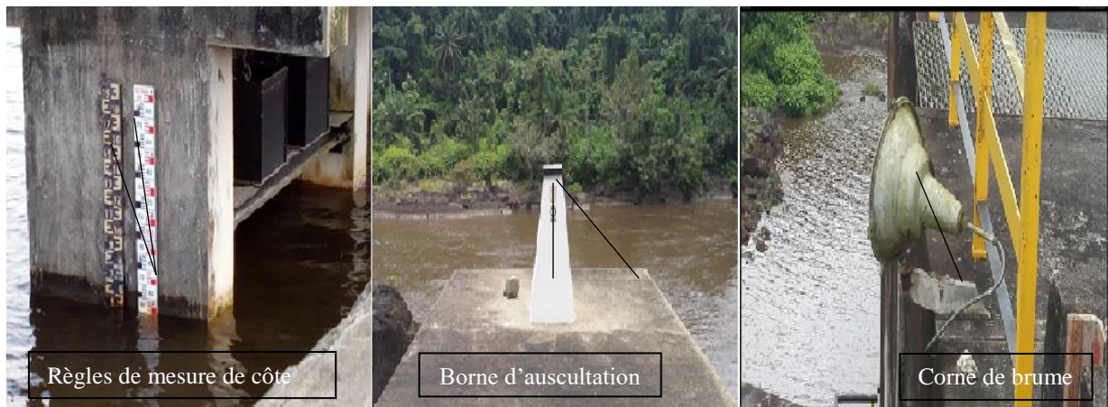
Planche 5 : Outils de sécurité des barrages d'Ayamé
