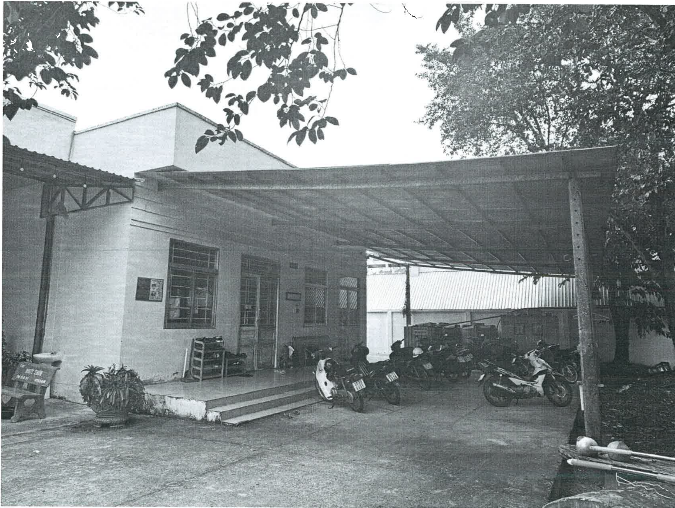
HÌNH ẢNH HIỆN TRẠNG NHÀ CHỜ CA
