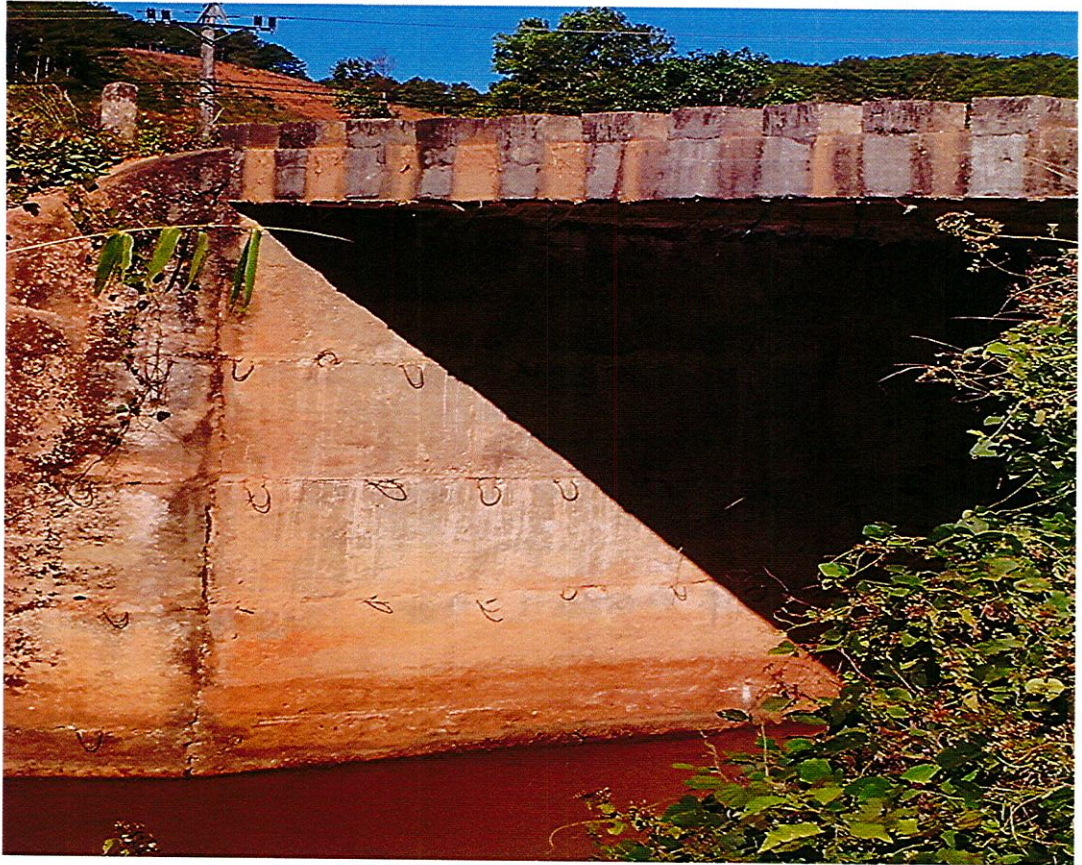
Hiện trạng cầu bản còn tốt
