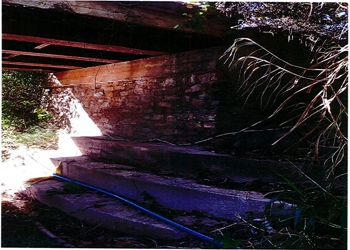
Mố M2 bằng đá hộc xây
