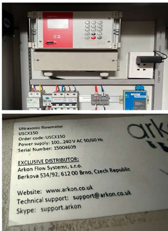
HÌNH: HỆ THỐNG QUAN TRẮC, GIÁM SÁT KHAI THÁC NƯỚC MẶT HIỆN HỮU
