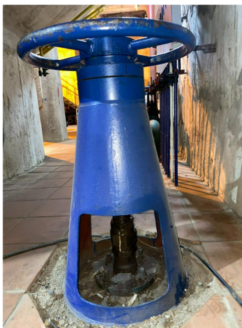
Hình ảnh van nắm tháo cạn Tổ máy bị han gỉ, bong tróc sơn nhiều vị trí
