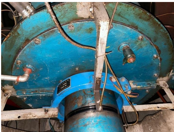
Hình ảnh đáy ổ hướng dưới máy phát có hiện tượng thấm rò rỉ dầu
