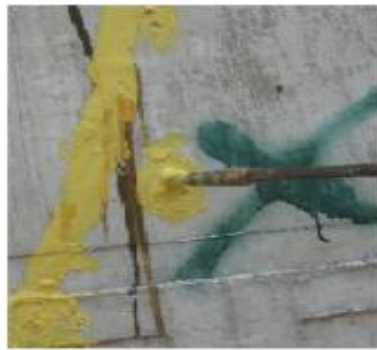
Tiến hành bơm keo vào bên trong tại các vị trí đã gắn kim bơm
