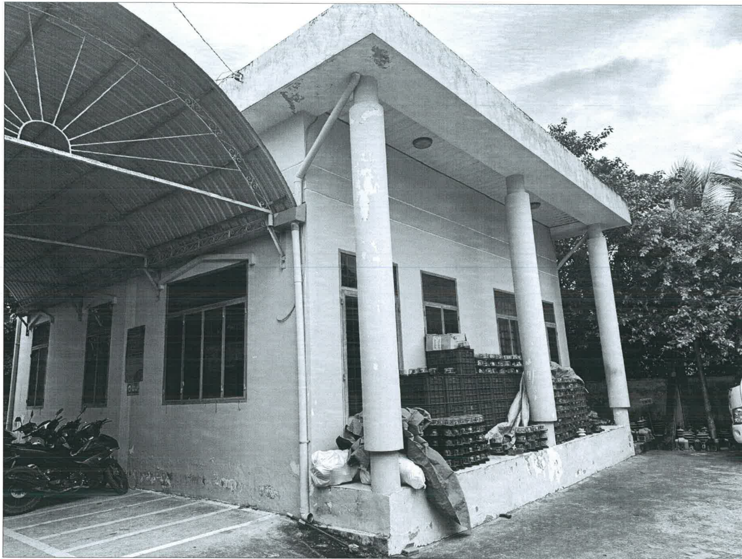
HÌNH ẢNH HIỆN TRẠNG NHÀ CÔNG VỤ
