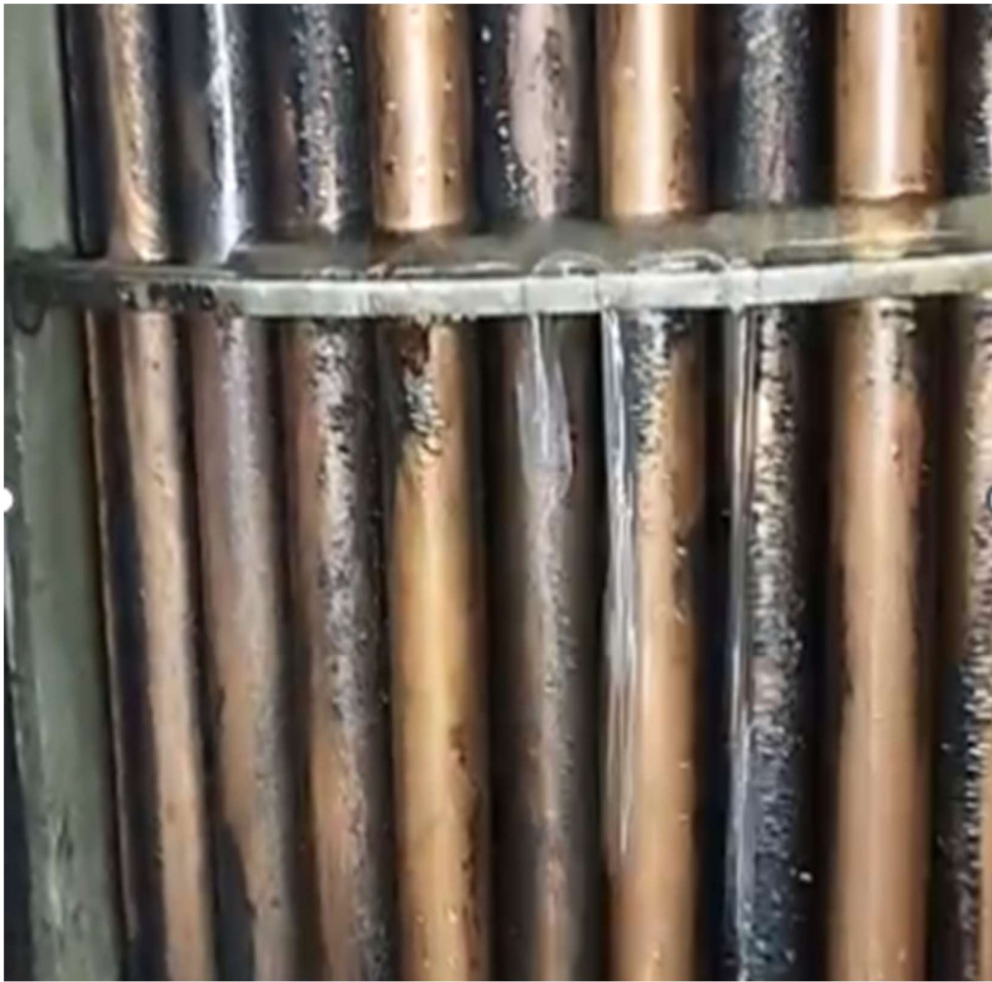
Hình ảnh nước chảy thành dòng do thùng ống đồng đối với bộ làm mát điều tốc H2, H3
