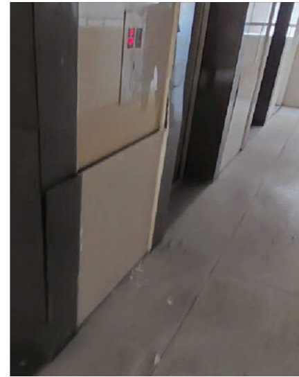
HÌNH 5 : THAY GẠCH ỐP TƯỜNG THANG MÁY ( 4 VIÊN ) LẦU 14
