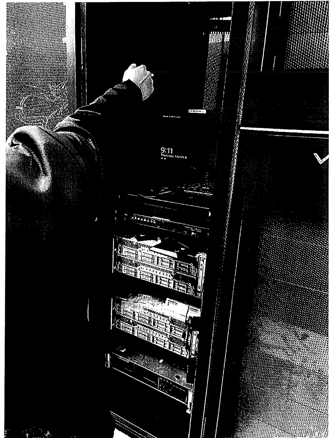
Tủ rack lắp đặt máy chủ
