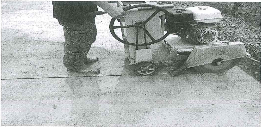
Công tác thi công khe được thực hiện một trong hai phương pháp nêu dưới đây:
