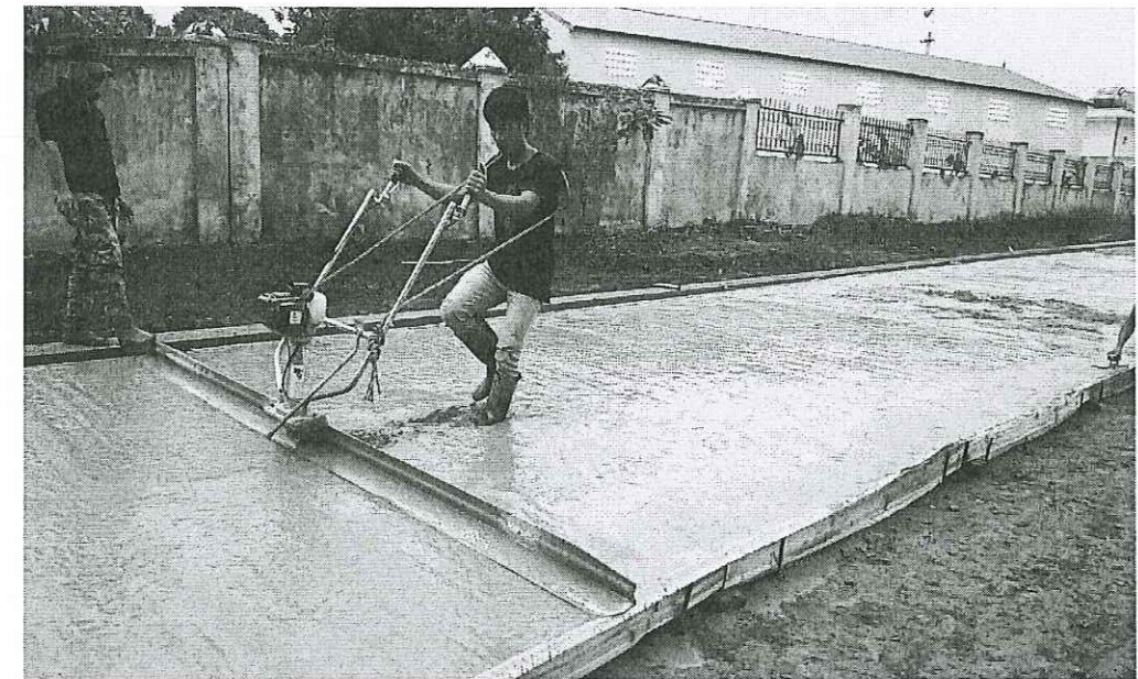
Đầm ngựa tạo mài luyện trong thi công mặt đường bê tông
