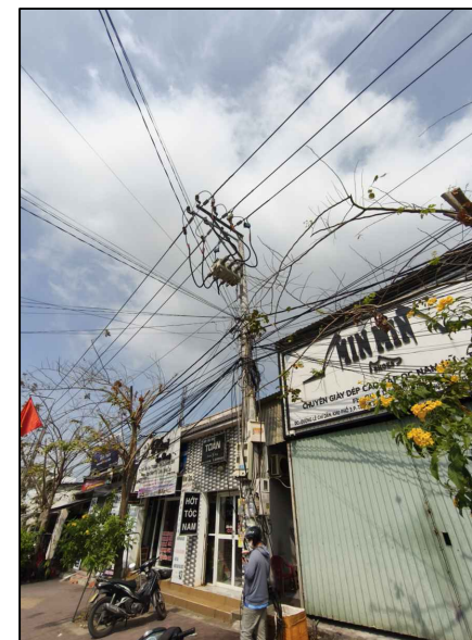
TRỤ 01B HIỆN HỮU NR LÒ LU TUYẾN 481 SAO QUỲ
