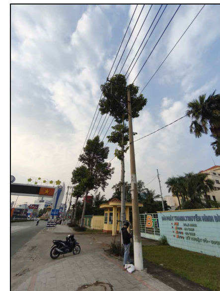
TRỤ 53 HIỆN HỮU TUYẾN 472 SƯ BÃO
