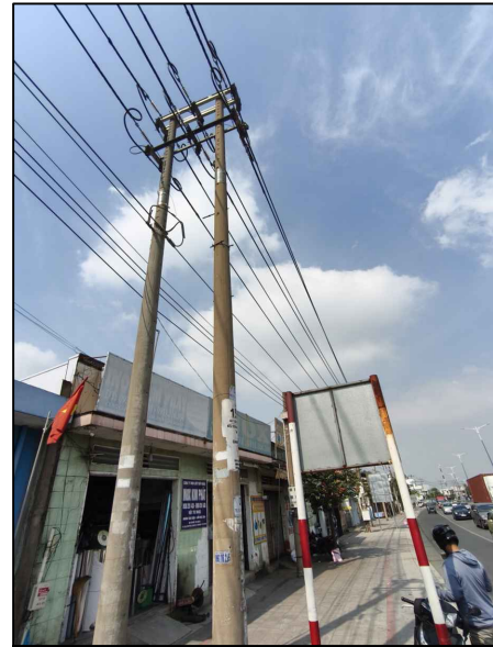
TRỤ 153 HIỆN HỮU TUYẾN 472 BỤNG CẦU
