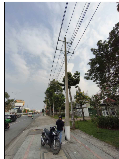
TRỤ 26 HIỆN HỮU TUYẾN 482 THANH HÒA
