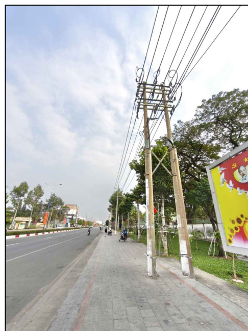
TRỤ 25 HIỆN HỮU TUYẾN 482 THANH HÒA
