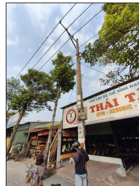
TRỤ 17 HIỆN HỮU NR PHÚ HÒA TUYẾN 478 SUỐI CÁT
