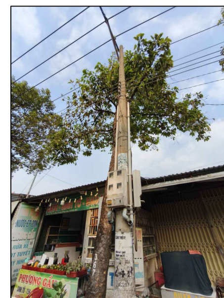
TRỤ 25 HIỆN HỮU NR PHÚ HÒA TUYẾN 478 SUỐI CÁT
