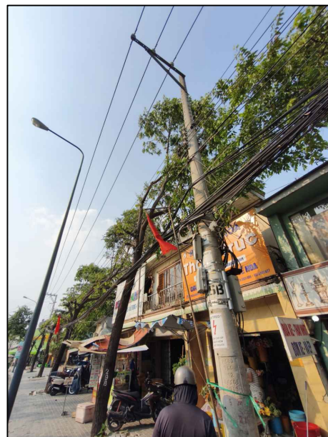
TRỤ 25B HIỆN HỮU NR SỞ CÔNG AN TUYẾN 474 MŨI DÙI
