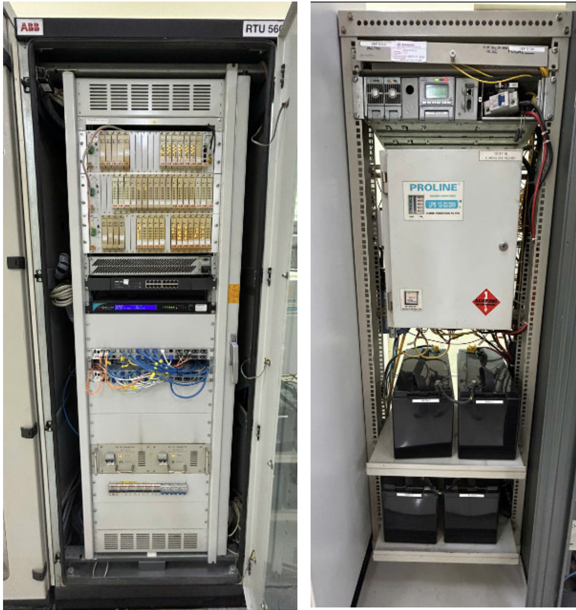
Hình ảnh hệ thống thông tin liên lạc và nguồn 48VDC
