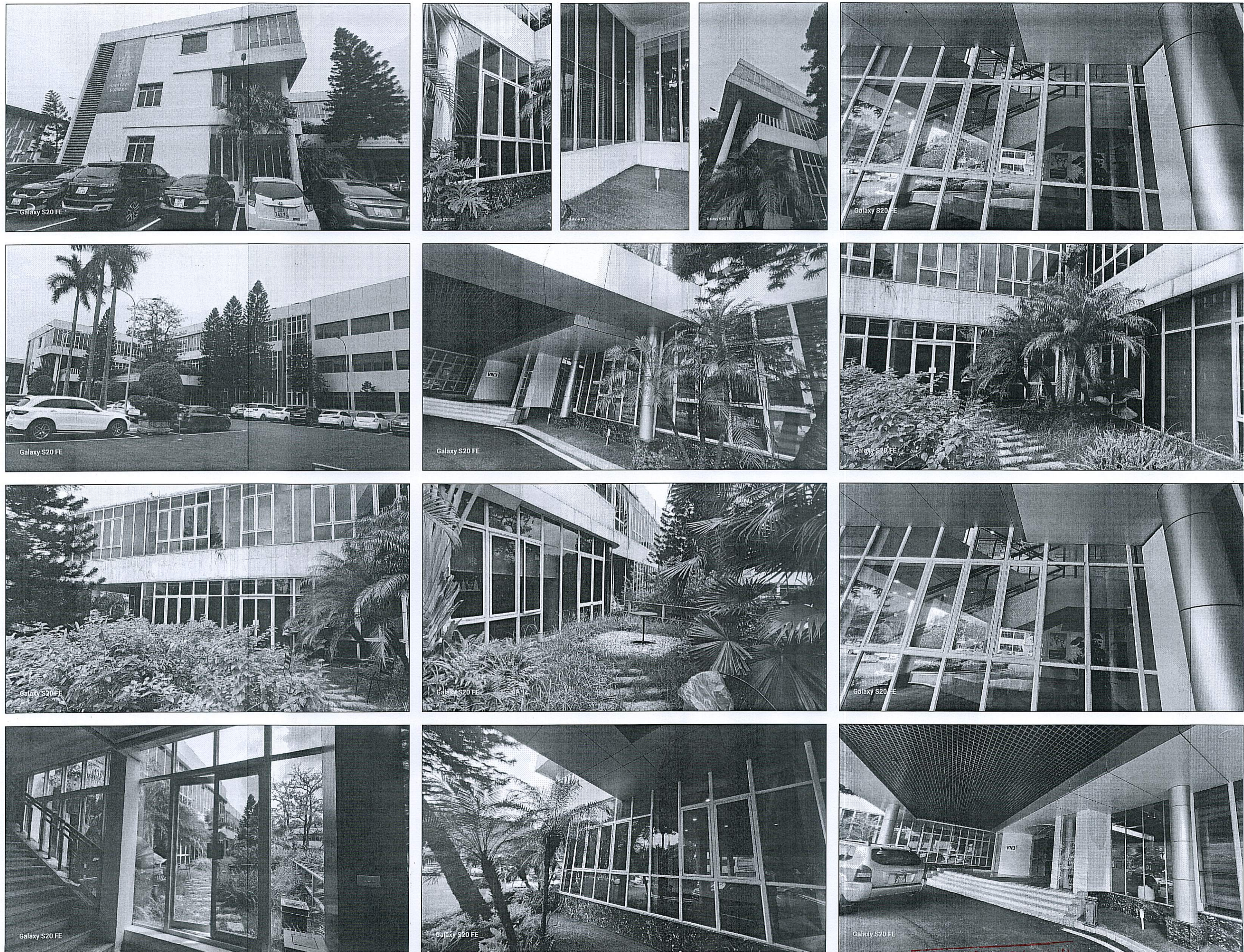
CÁC GÓC HÌNH CHỤP HIỆN TRẠNG
