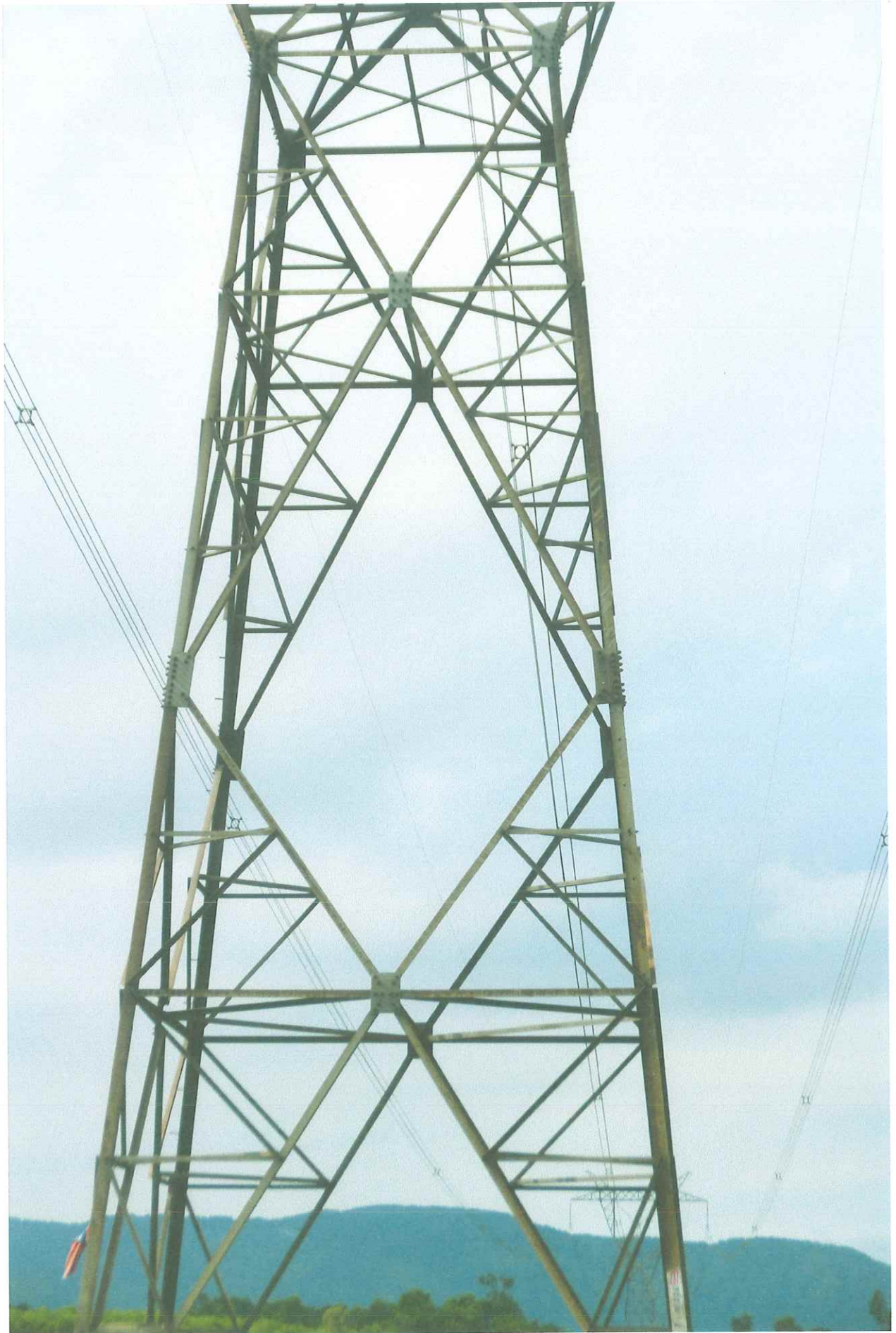
VỊ TRÍ: 303 ĐZ 500KV 573,563 NMĐNS2 - 580,581 T500HT
