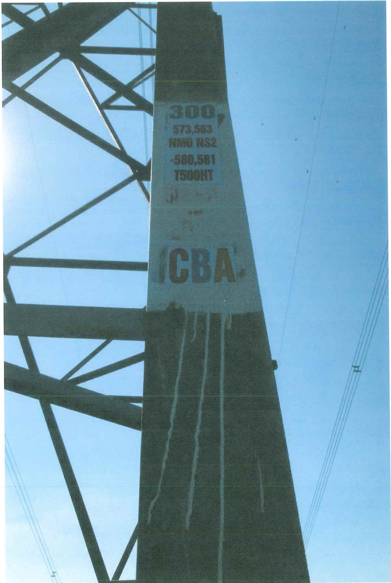
VỊ TRÍ: 300 ĐZ 500KV 573,563 NMĐNS2 - 580,581 T500HT
