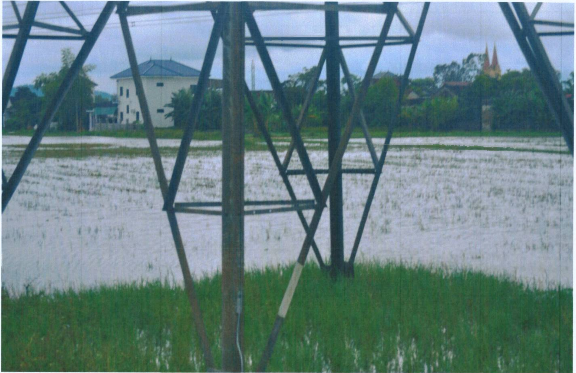
VỊ TRÍ 213 ĐZ 500KV 573,563 NMĐNS2 – 580,581 T500HT
