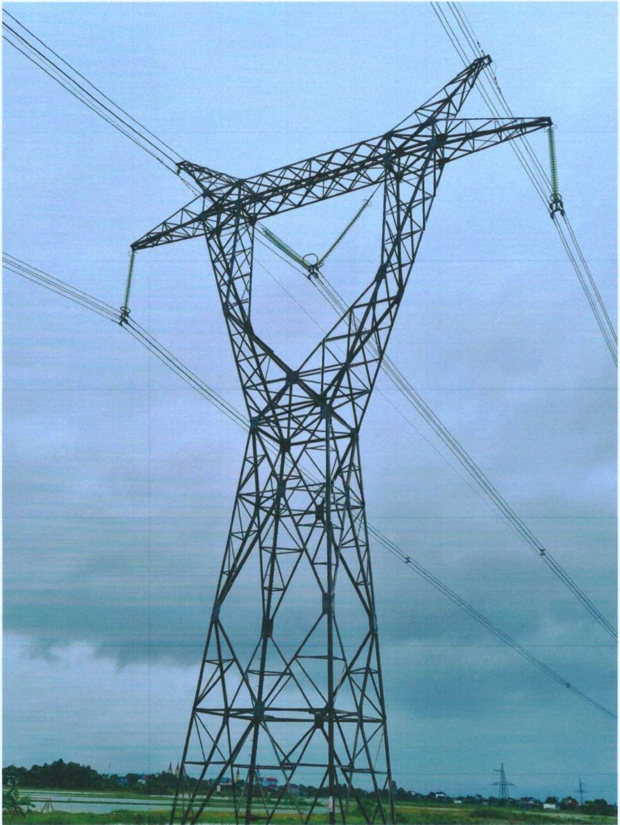
VỊ TRÍ 213 ĐZ 500KV 573,563 NMĐNS2 – 580,581 T500HT
