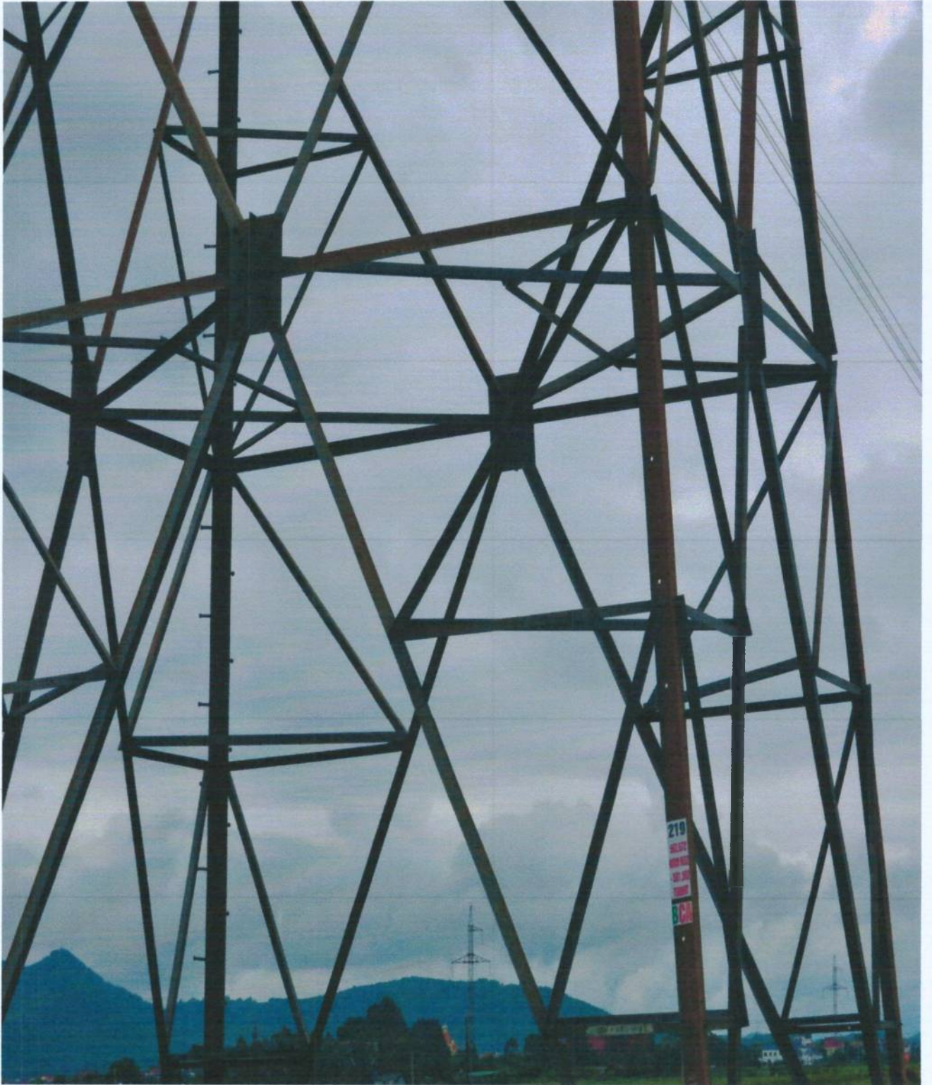
VỊ TRÍ 219 ĐZ 500KV 572,562 NMĐNS2 – 581,582 T500HT
