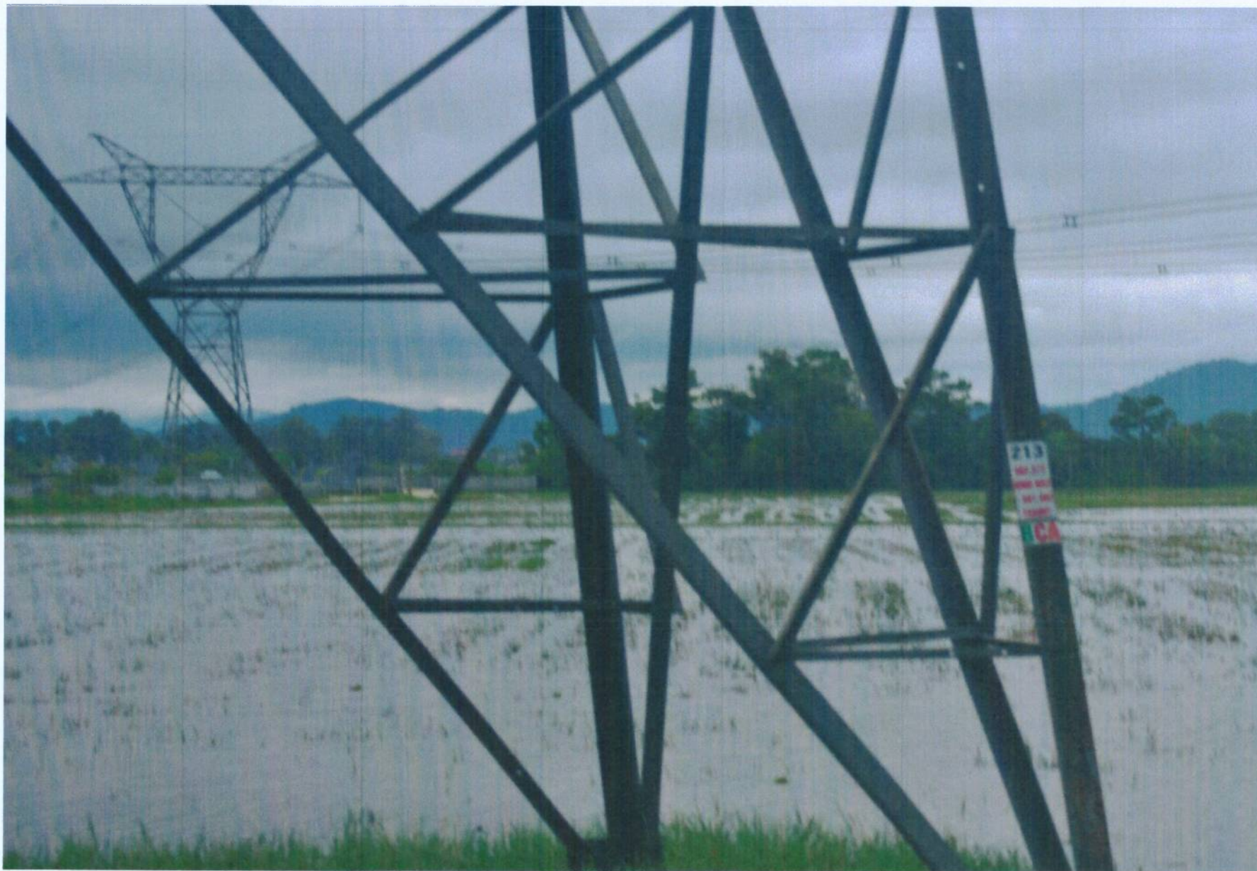
VỊ TRÍ 213 ĐZ 500KV 573,563 NMĐNS2 – 580,581 T500HT
