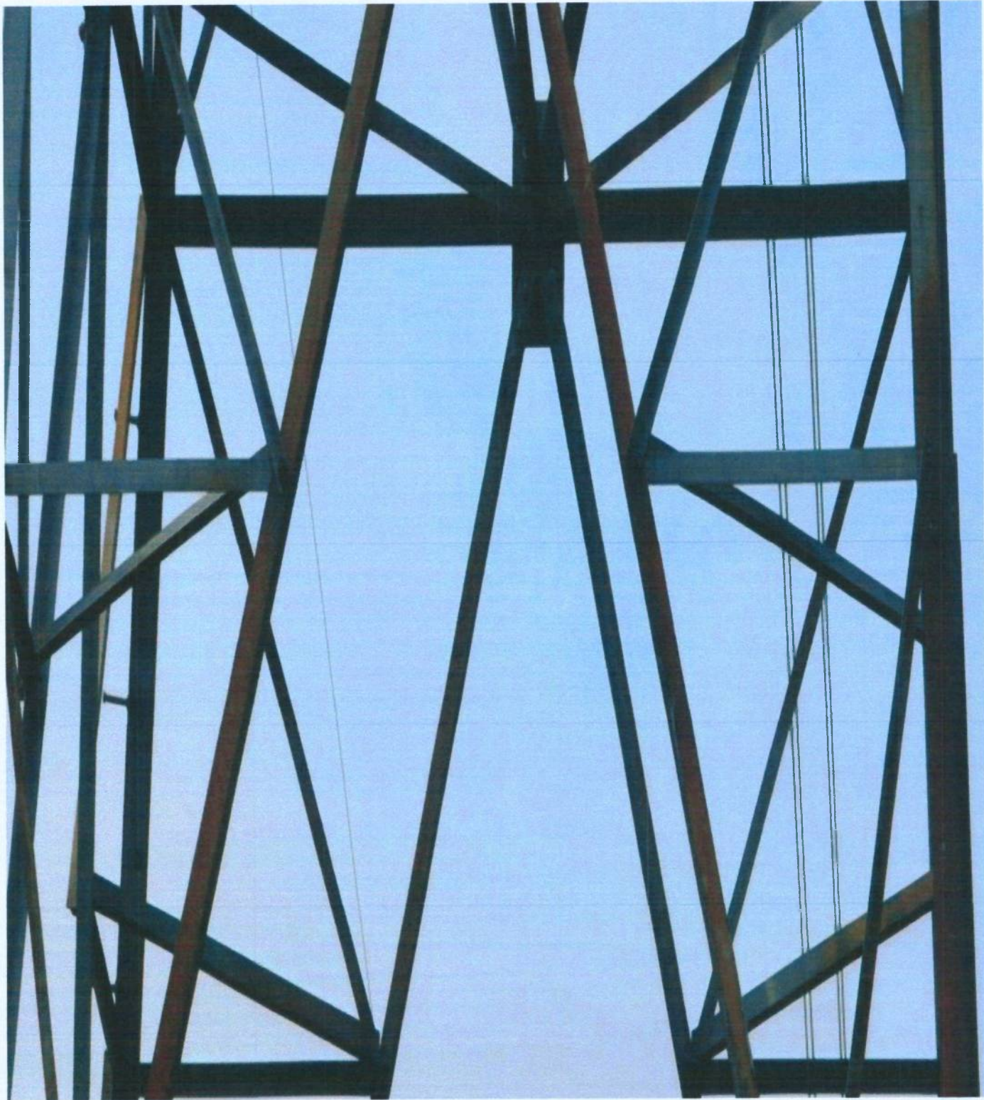
VỊ TRÍ 194 ĐZ 500KV 573,563 NMĐNS2 – 580,581 T500HT
