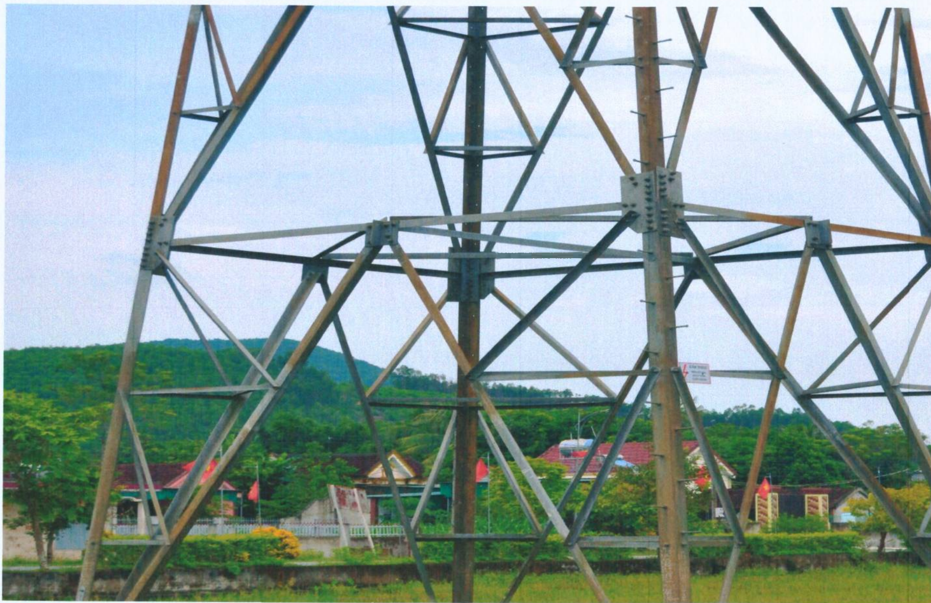
VỊ TRÍ 164 ĐZ 500KV 573,563 NMĐNS2 – 580,581 T500HT
