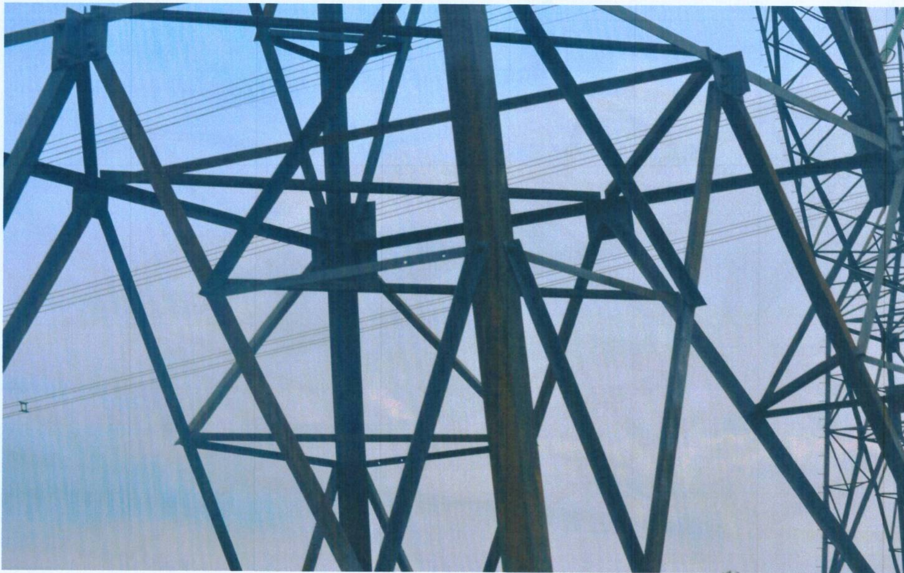
VỊ TRÍ 194 ĐZ 500KV 573,563 NMĐNS2 – 580,581 T500HT
