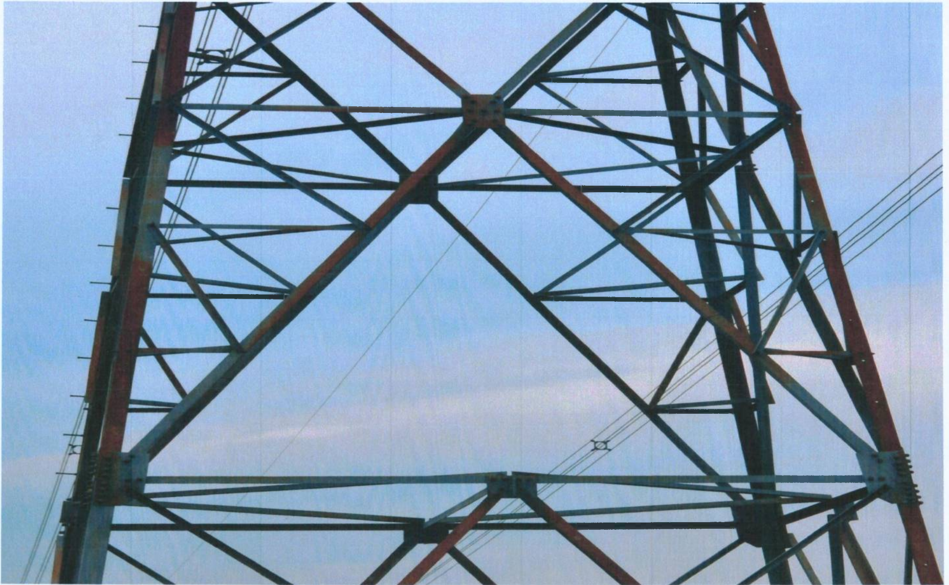
VỊ TRÍ 164 ĐZ 500KV 573,563 NMĐNS2 – 580,581 T500HT
