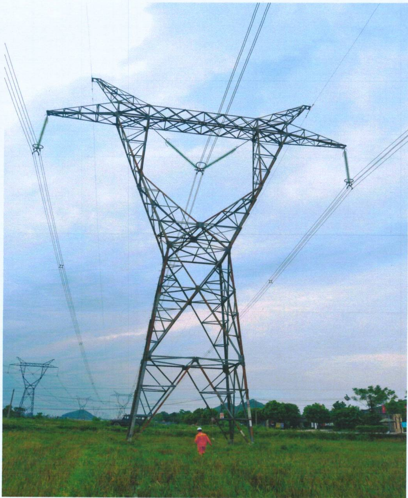
VỊ TRÍ 164 ĐZ 500KV 573,563 NMĐNS2 – 580,581 T500HT
