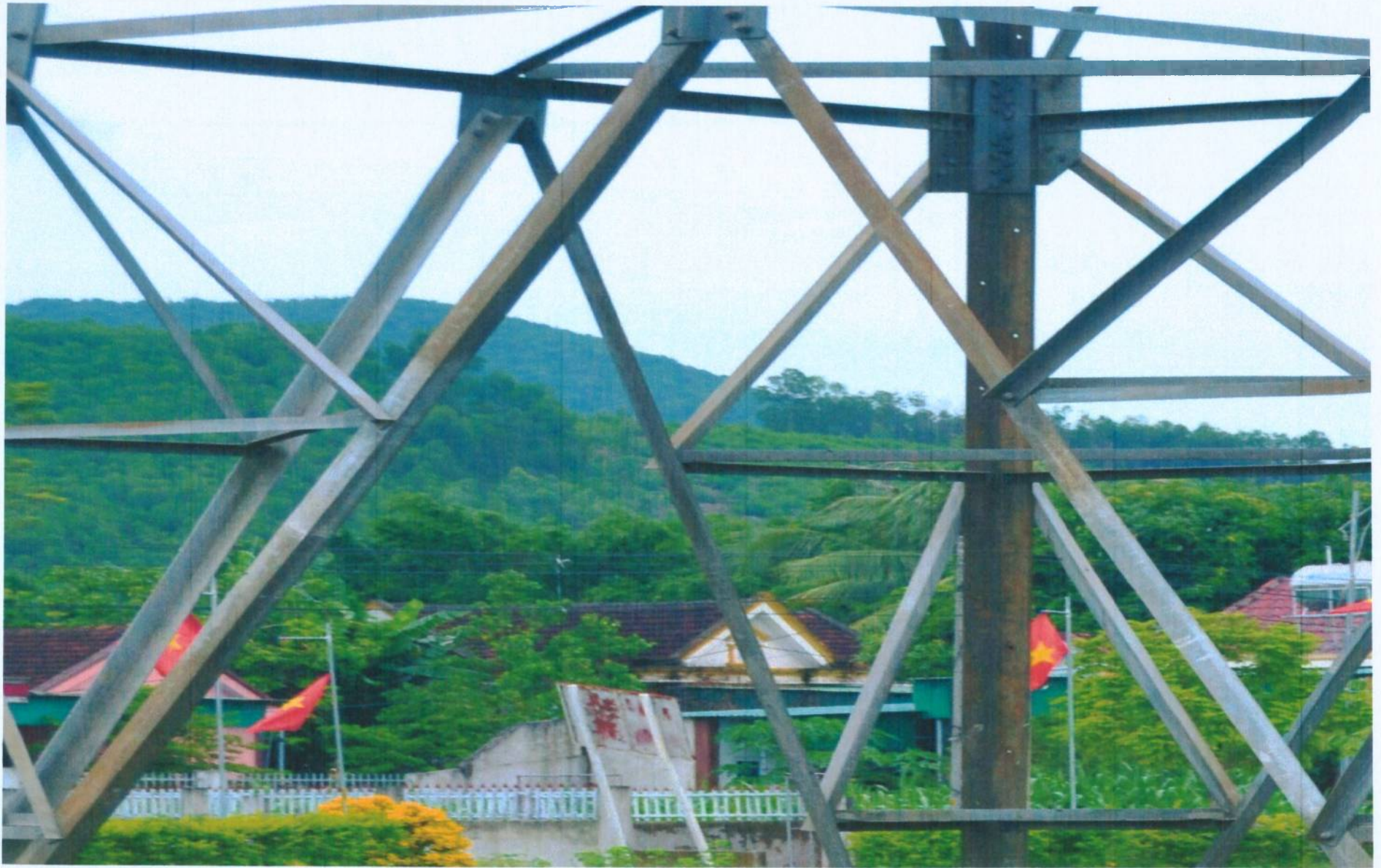
VỊ TRÍ 164 ĐZ 500KV 573,563 NMĐNS2 – 580,581 T500HT
