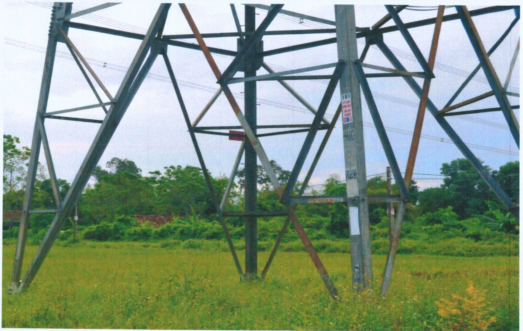
VỊ TRÍ 191 ĐZ 500KV 573,563 NMDNS2 – 580,581 T500HT
