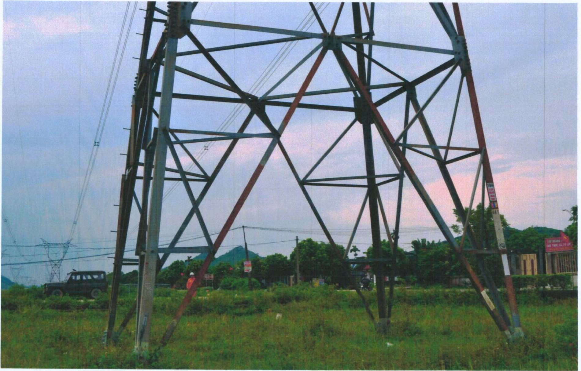
VỊ TRÍ 164 ĐZ 500KV 573,563 NMĐNS2 – 580,581 T500HT
