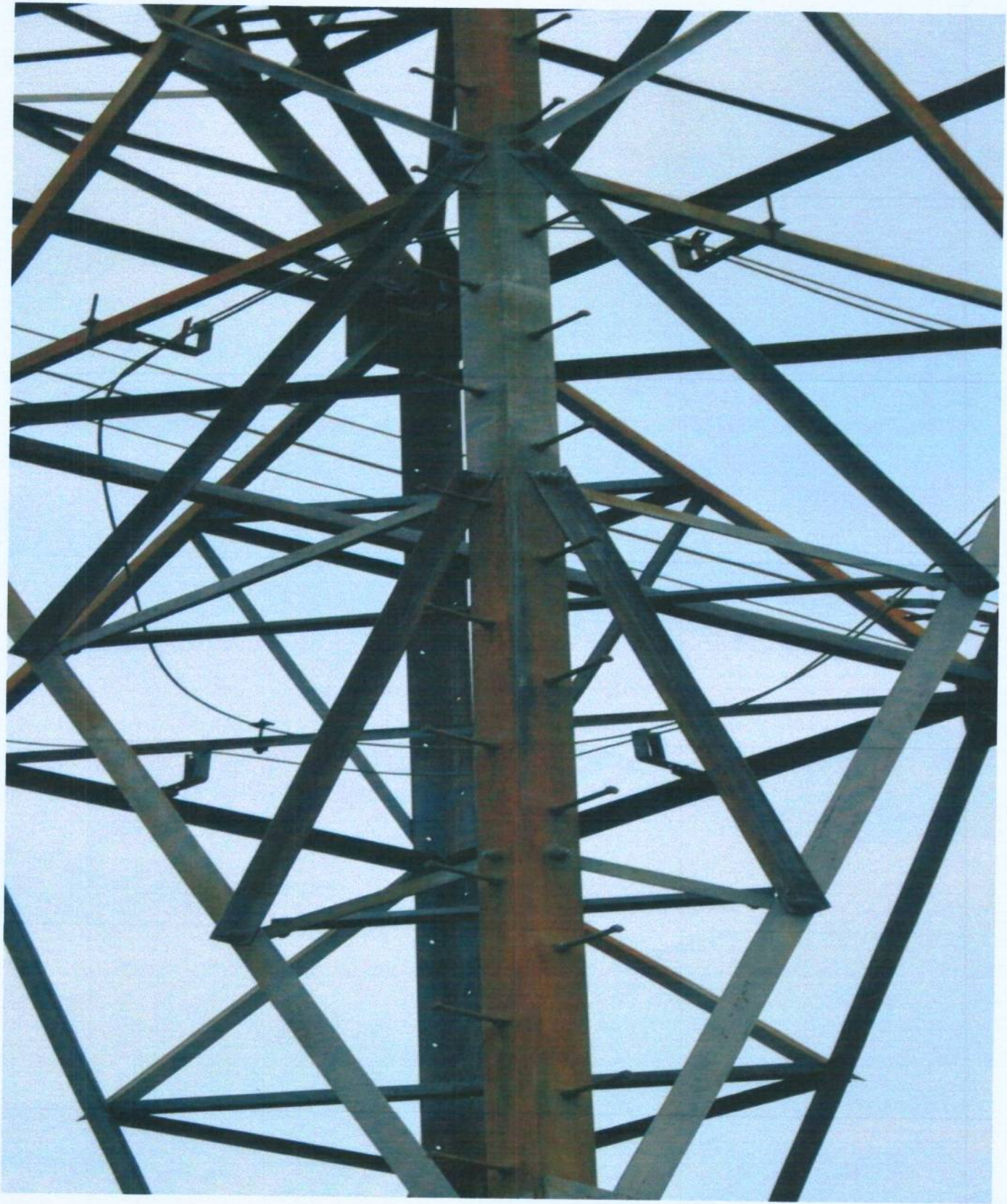
VỊ TRÍ 191 ĐZ 500KV 573,563 NMĐNS2 – 580,581 T500HT
