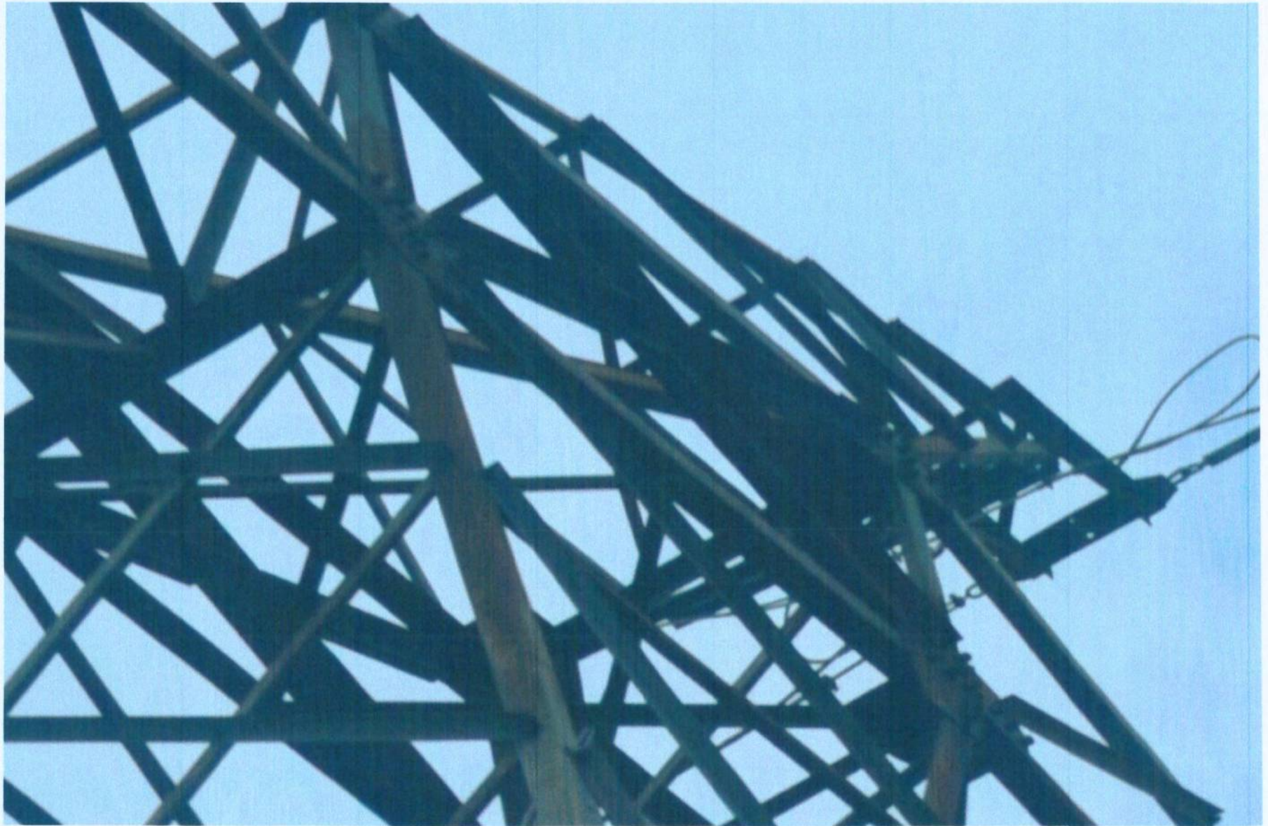
VỊ TRÍ 191 ĐZ 500KV 573,563 NMĐNS2 – 580,581 T500HT
