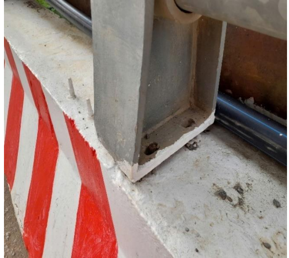
Lan can cầu bằng thép mạ kẽm mất ê cu
