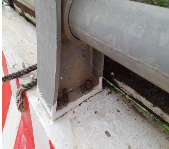
Lan can cầu bằng thép mạ kẽm mất ê cu
