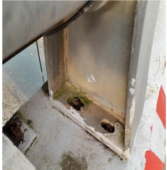
Lan can cầu bằng thép mạ kẽm mất ê cu
