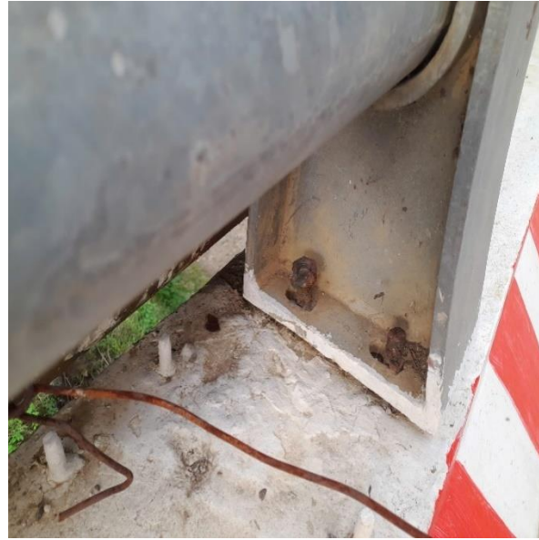
Lan can cầu bằng thép mạ kẽm mất ê cu
