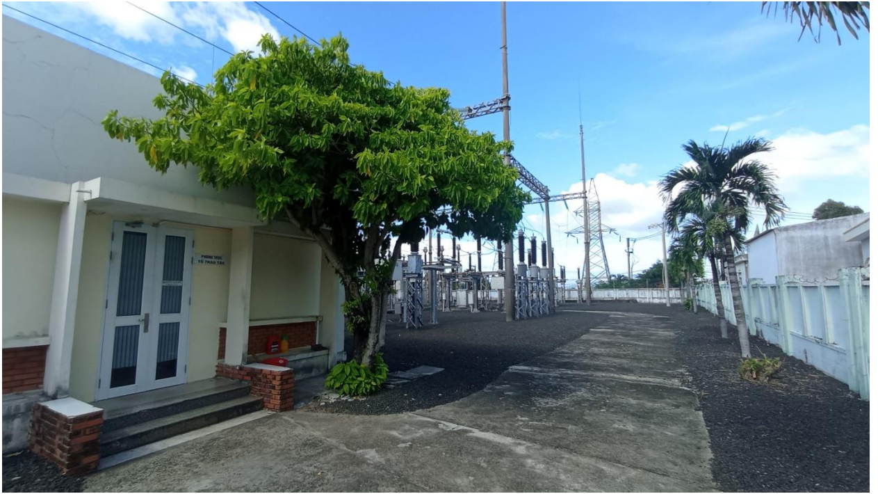
Hình 1. Lối đi vào Trạm biến áp 110kV Tuy Hòa hiện trạng
