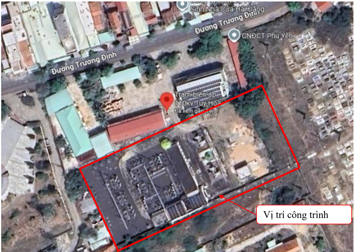
Vị trí Trạm biến áp 110kV Tuy Hòa
