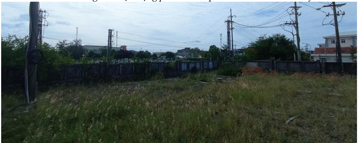
Hình 5. Tường rào hiện trạng phía Tây TBA 110kV Tuy Hòa
