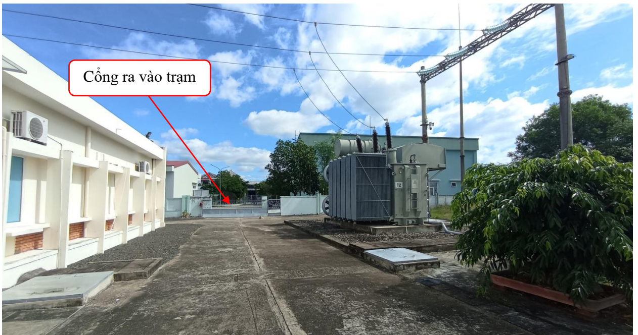
Hình 2. Cổng ra vào Trạm biến áp 110kV Tuy Hòa hiện trạng
