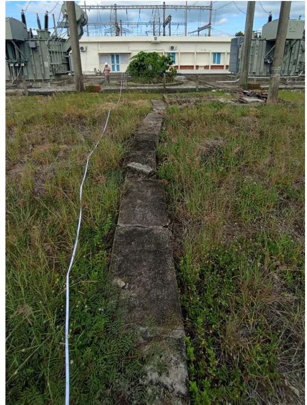
Hình 9. Mương cáp ngầm hiện trạng cần cải tạo
