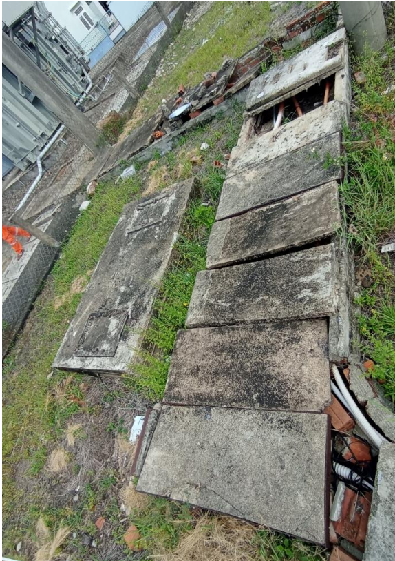
Hình 9. Mương cáp ngầm hiện trạng cần cải tạo
