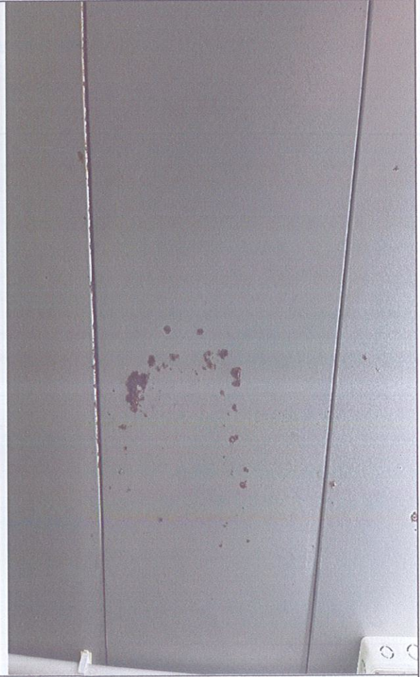
Hình ảnh các tấm trần thép hoen rỉ
