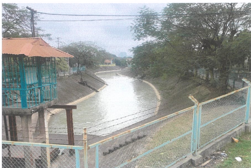
Hình 6. Kênh xả trạm bơm Ấp Bắc
