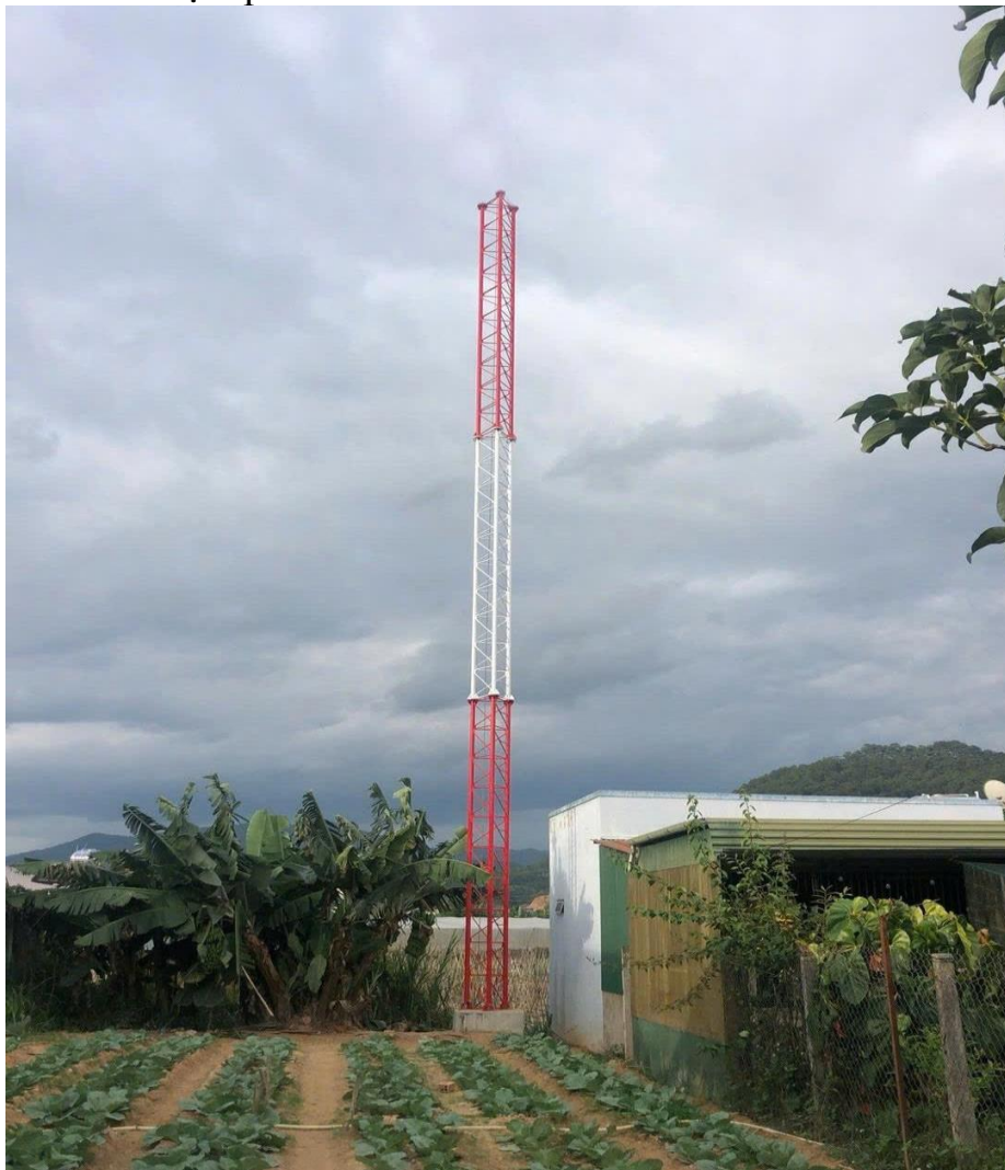
Hình 5: Hình cột tam giác roll 600 ống 60 (tự đứng 9 mét)
