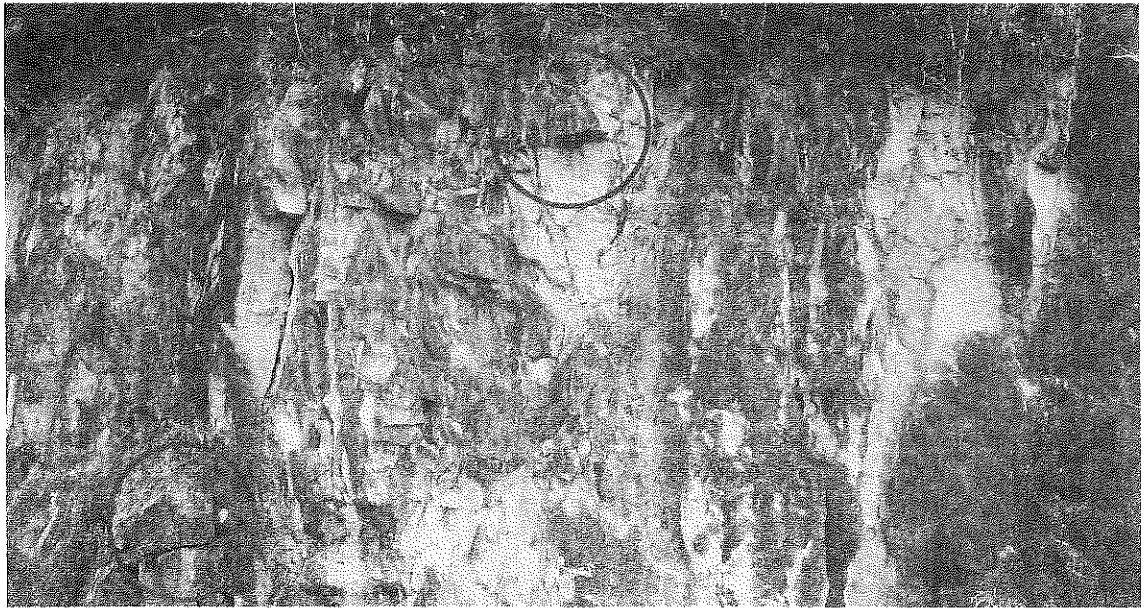
Hình 3: Các hòn đá có nguy cơ bị rơi cần được tẩy đi trước khi gia cố mái taluy
