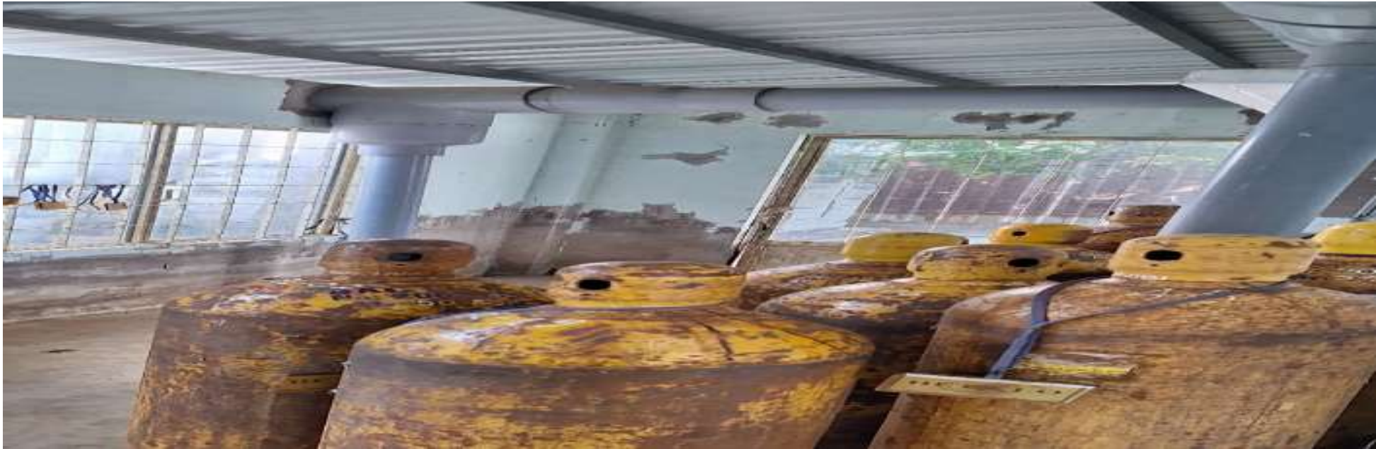
Hình 0-3. Hình ảnh nhà clo hiện hữu
