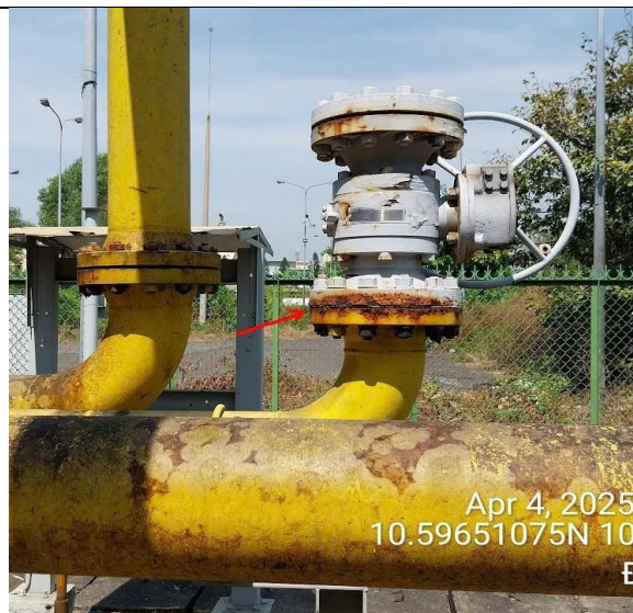
Hình ảnh rỉ sét tại mặt bích Ball Valve đầu chờ 6" #300 trạm Kidwell (đi CNG VN)
