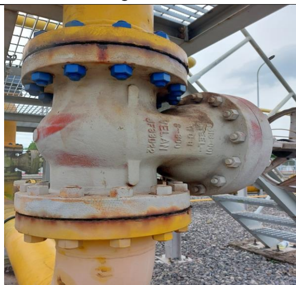
Hình ảnh rỉ sét tại mặt bích Ball Valve đầu chờ 6" #300 trạm Kidwell (đi CNG VN)
