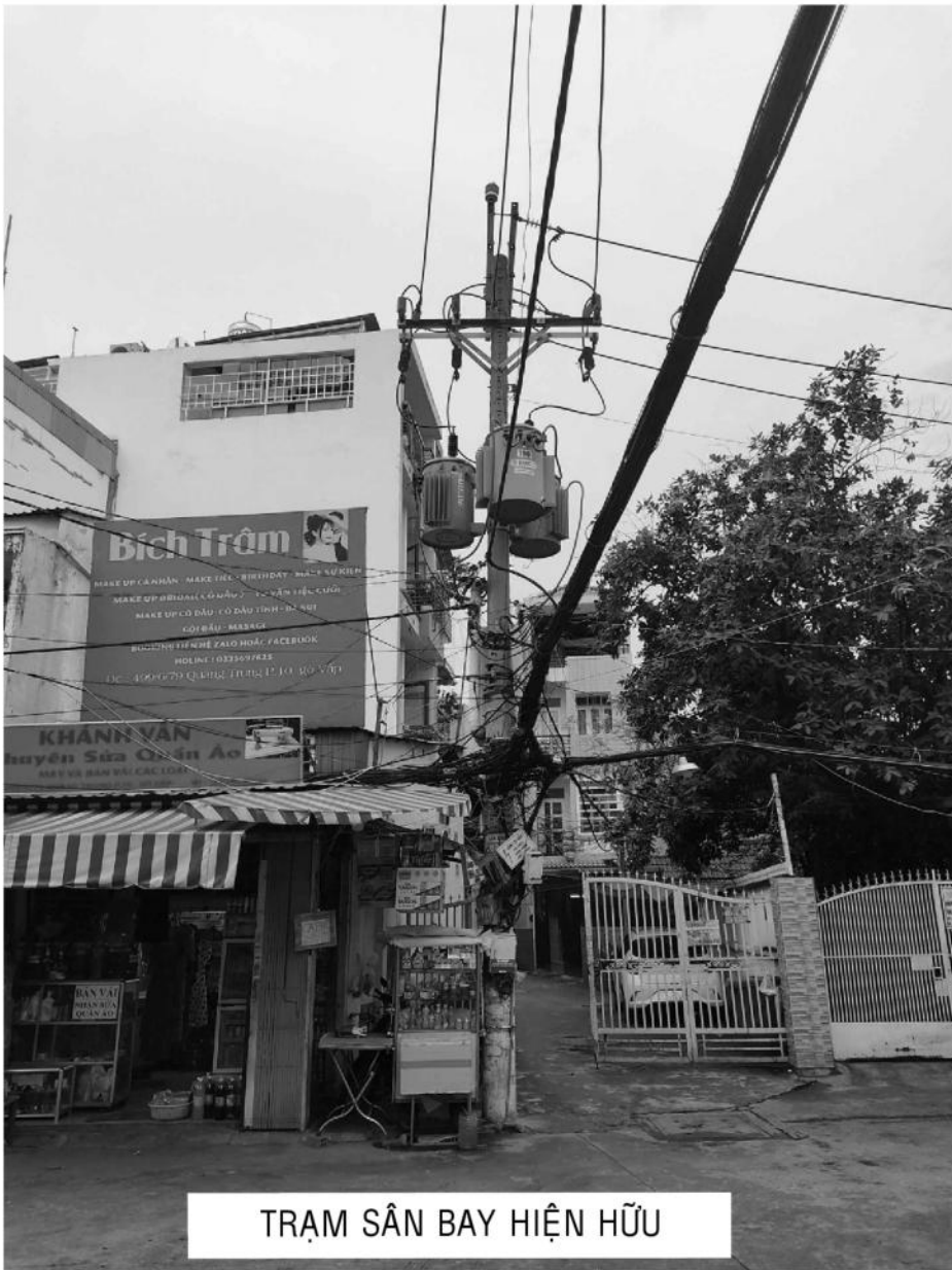
TRẠM SÂN BAY HIỆN HỮU
