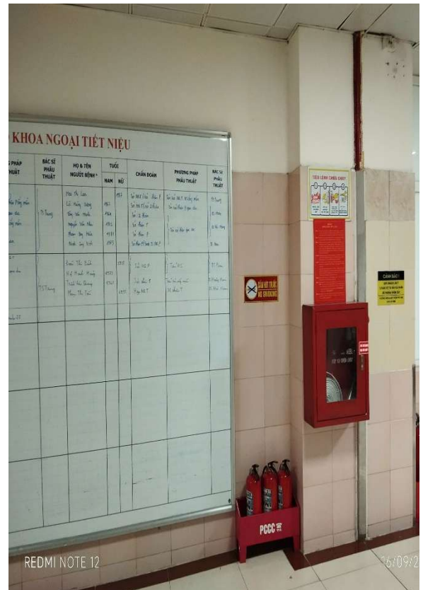
Hình 2: Gạch ốp tường chấp và không đồng màu
