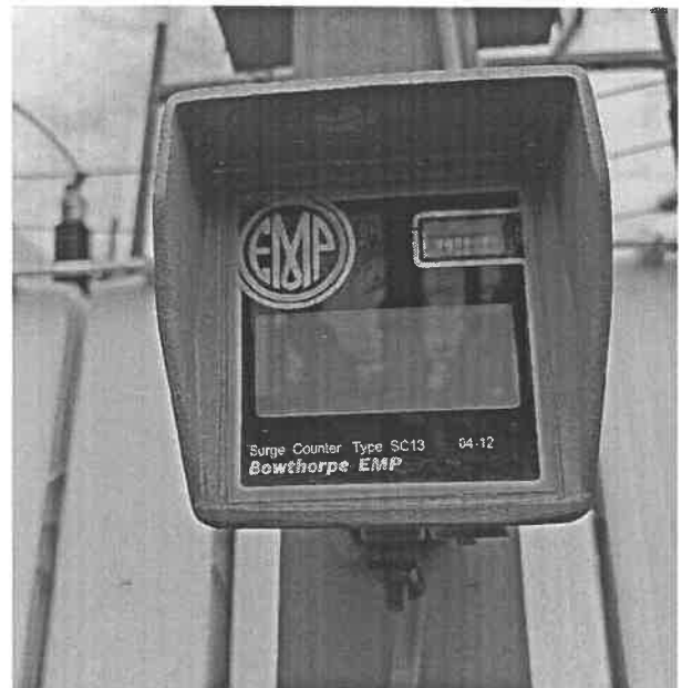
Hình ảnh đồng hồ đếm sét pha B CS1T1
