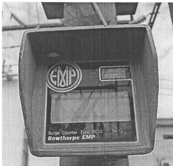
Hình ảnh đồng hồ đếm sét pha C CS1T1
