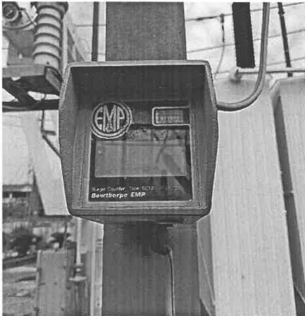
Hình ảnh đồng hồ đếm sét pha A CS1T1
