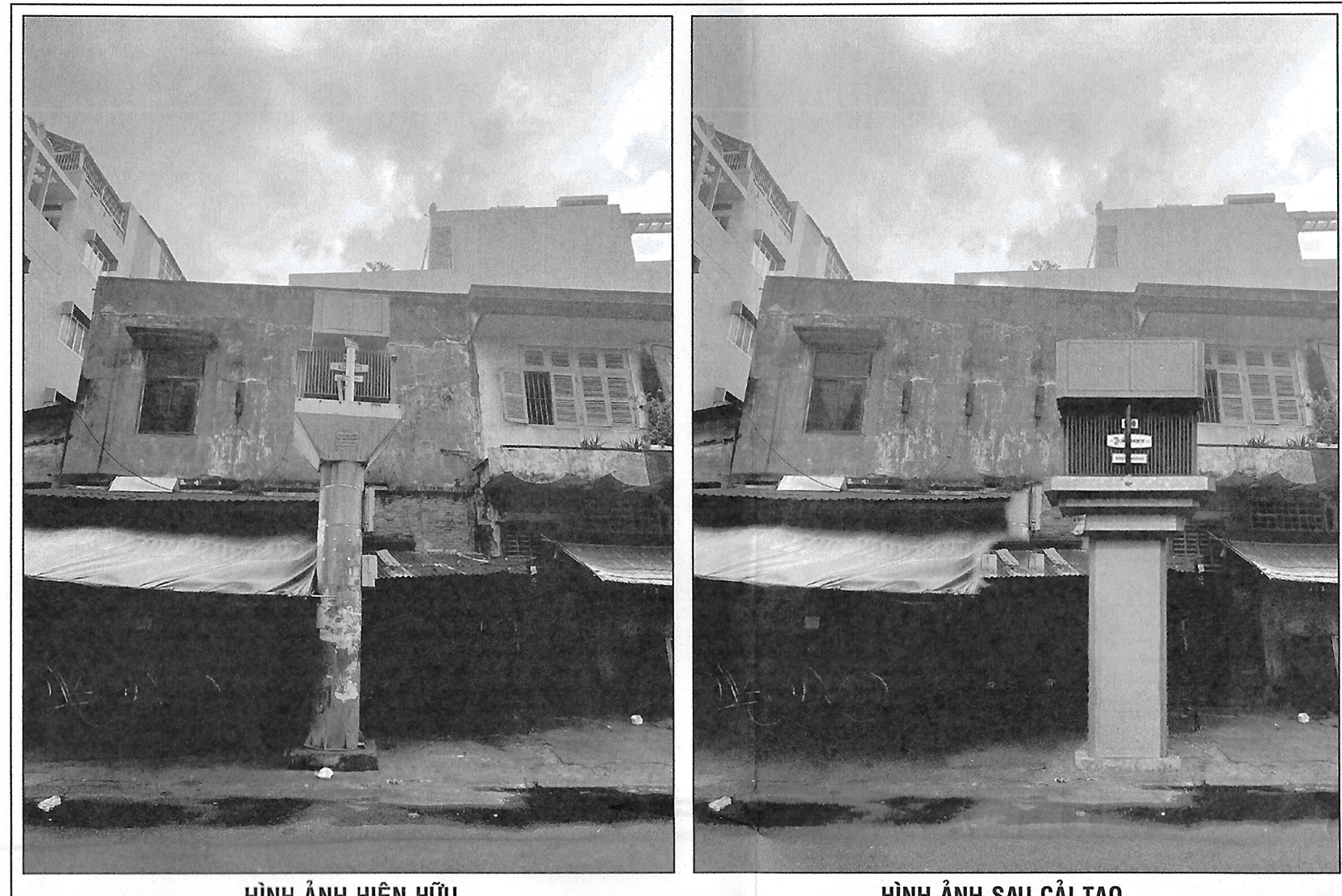
HÌNH ẢNH TRẠM CHỢ THIẾC TRƯỚC VÀ SAU CẢI TẠO BÊN HONG NHÀ 164 PHỐ CỐ ĐIỀU
