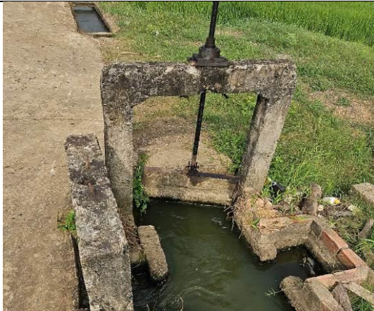
Hình Error! No text of specified style in document.-22: Hiện trạng cửa chia nước – vị trí 1
