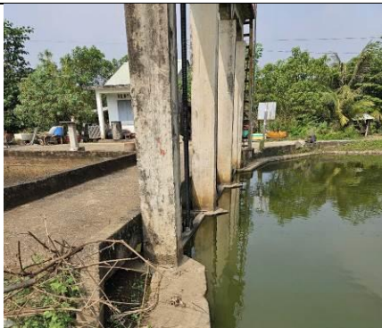
Hình Error! No text of specified style in document.-4: Hiện trạng cầu công tác vận hành cửa van
