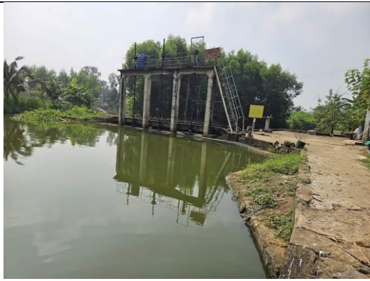
Hình Error! No text of specified style in document.-6: Hiện trạng tường cánh, đoạn cửa vào phía thượng lưu đập
