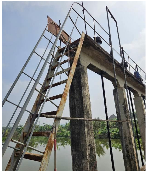
Hình Error! No text of specified style in document.-9: Hiện trạng cầu thang, lan can
