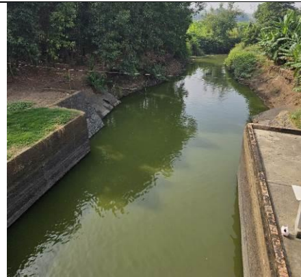
Hình Error! No text of specified style in document.-7: Hiện trạng tường cánh, đoạn cửa ra phía hạ lưu đập
