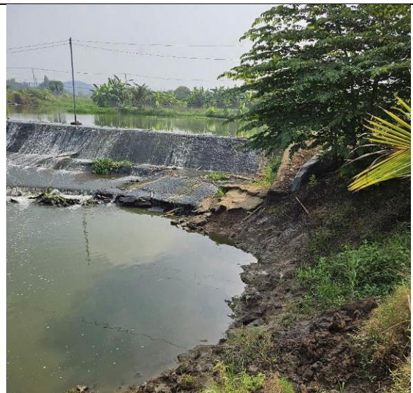
Hình Error! No text of specified style in document.-13: Hiện trạng tràn sự cố - vai trái
