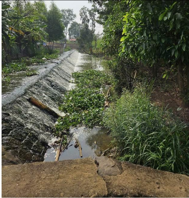
Hình Error! No text of specified style in document.-14: Hiện trạng tràn sự cố – vai trái
