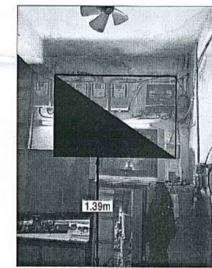
HÌNH ẢNH CÁC VỊ TRÍ DỰ KIẾN LẮP ĐẶT TỦ ĐIỆN LÒ F2 - CHUNG CƯ NGUYỄN THIỆN THUẬT ĐIỆN HÌNH
